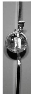
Detail: Seitenansicht der Leitbleche mit angeschweißter Bimetallwendel
